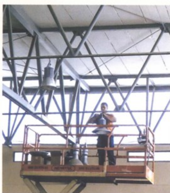
Detalj izvođenja radova
