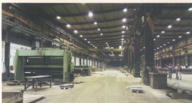
Osvjetljenje u proizvodnoj hali prije zamjene rasvjete
