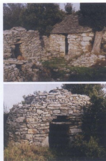
▲ Primjeri tradicijske arhitekture u kojoj je korišten pločasti vapnenac kao građevni kamen, otok Hvar
